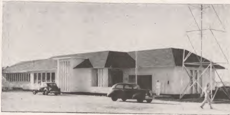
Edificio de Correos, Radio y Teléfono.
